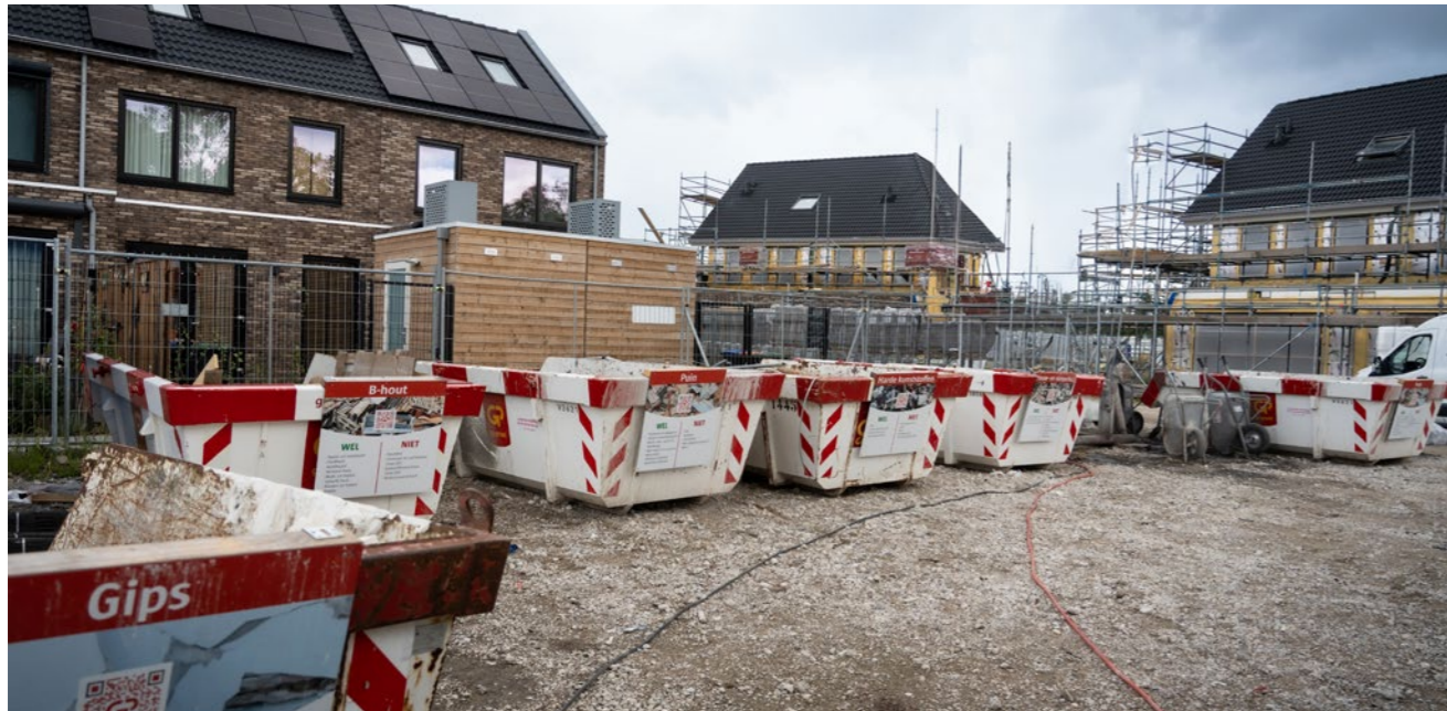
Om bijvoorbeeld beton en gips te kunnen hergebruiken, blijft afvalscheiding op de bouwplaats erg belangrijk.
